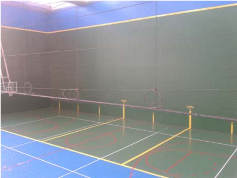
ZONA CENTRAL DE LA PISTA DEL FRONTÓ
