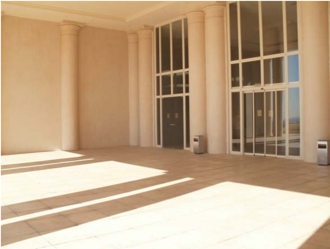
VISTA TERRASSA COBERTA POSTERIOR – INEFC Barcelona
