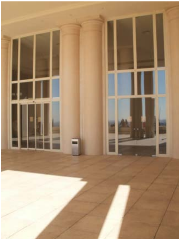
VISTA TERRASSA COBERTA POSTERIOR – INEFC Barcelona
