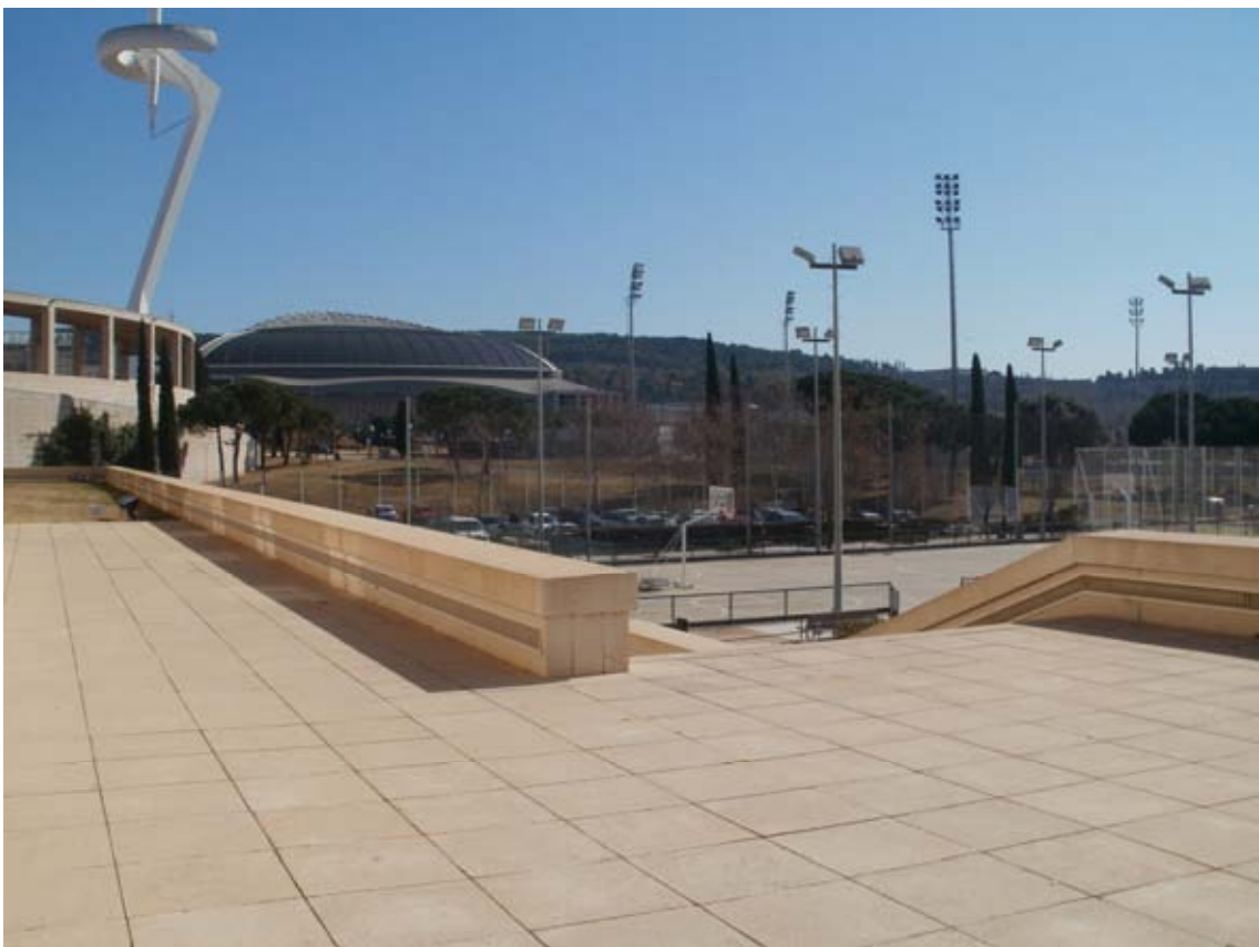
VISTA POSTERIOR DESDE LA TERRASSA COBERTA – INEFC Barcelona
